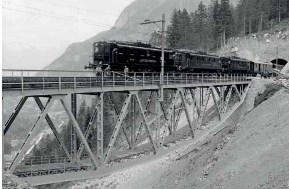
Švýcarská železnice z Bernu do Brigu byla od počátku stavěna jako elektrická dráha. Dobová fotografie zachycuje zkušební jízdu před jejím otevřením v létě 1913.
