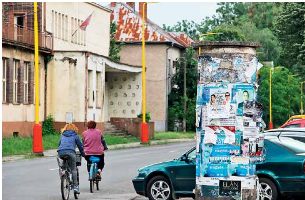
Opuštěný a chátrající Kulturní dům železničářů
