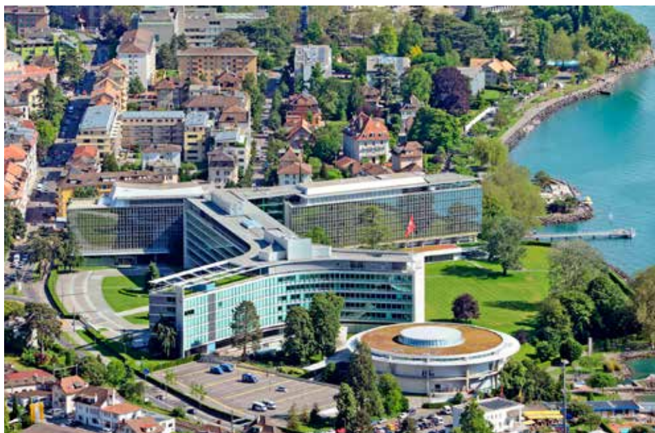
INOVACE SÍDLA. Starší část centrály budou tepelná čerpadla vytápět, dokud venkovní teplota neklesne pod osm stupňů. Pro novější budovu budou jediným zdrojem tepla.
