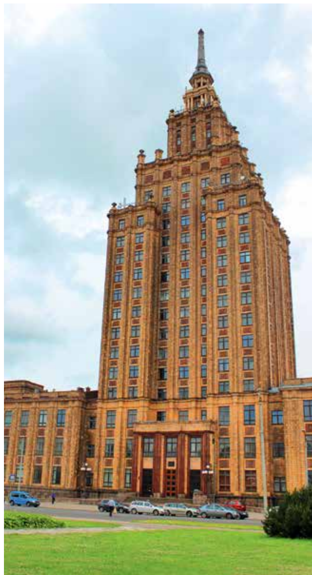
AKADEMIE VĚD. Budova postavená v padesátých letech připomíná pražský Hotel International.
