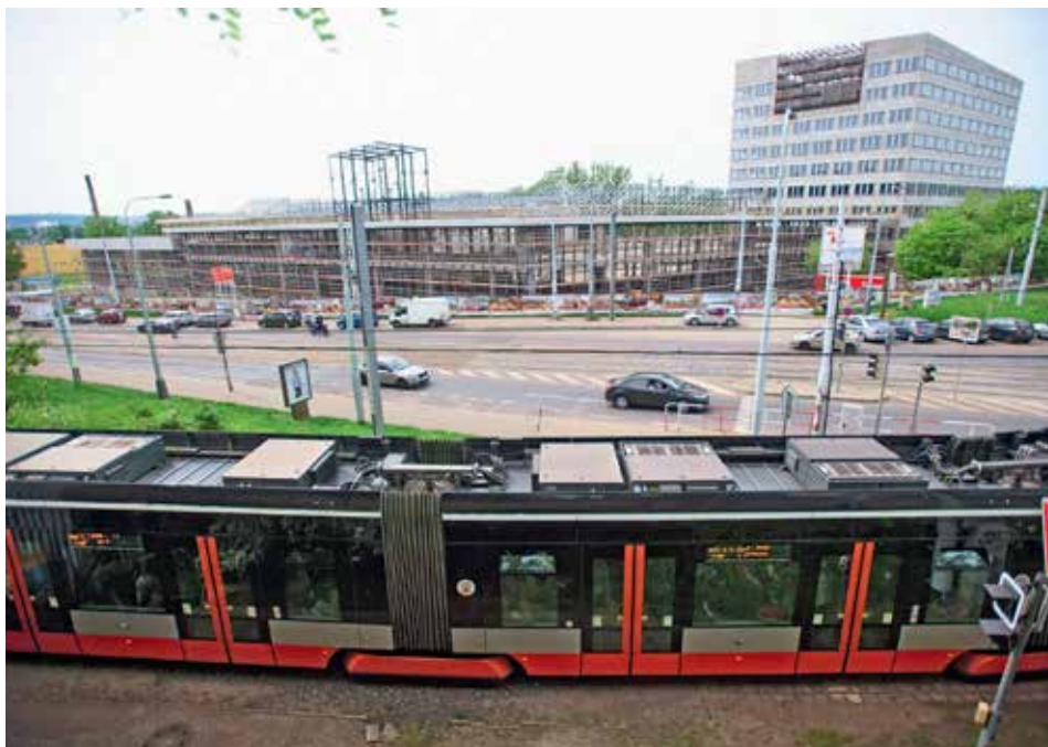
ZASTAVENÁ STAVBA. Výstavbu nové radnice Prahy 8 u Palmovky (na snímku vpravo) blokují spory se stavební firmou i žaloby na určení vlastnictví vznikajícího objektu.
