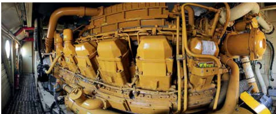
Strojovně dominuje vznětový motor CAT 3512 C.
