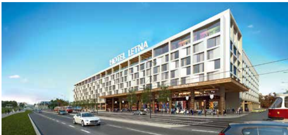
DOSTAVBA LETNÉ. Nový hotel a přestavba jižní části fotbalového stadionu Sparty v jeho těsné blízkosti udělají z Letné souvislý městský celek.
