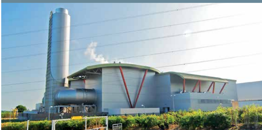
LANGAGE. Nová elektrárna Langage běží od roku 2010 a má výkon 885 megawattů.
