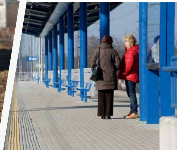
...druhé nástupiště v Úvalech již slouží cestujícím, byť některé detaily ještě čeká dokončení.
