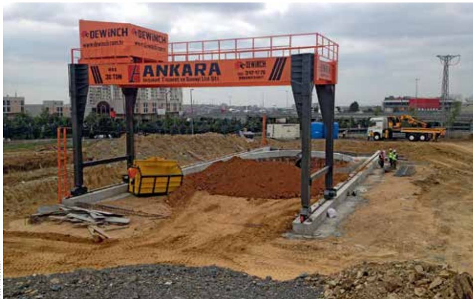
STÁTNI INVESTICE. Metrostav zahájil v Istanbulu stavbu depa metra. Stavebnictví v Turecku prodělává velký rozmach, mimo jiné díky státním investicím do dopravních staveb.
