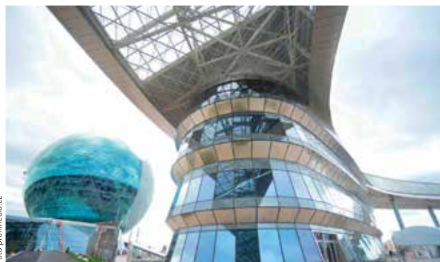
NA VLASTNÍ NÁKLADY. Stavbu nových národních pavilonů uhradil kompletně hostitelský Kazachstán.
