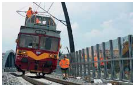
Dokončovací práce na novém mostě v Ústí nad Orlicí.
