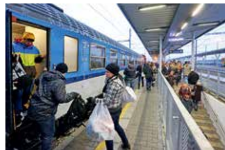
Modernizovaná nástupiště v Olomouci hl. n.
