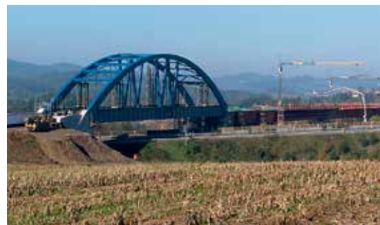
Budované přemostění dálnice D3 u Chotovin.
