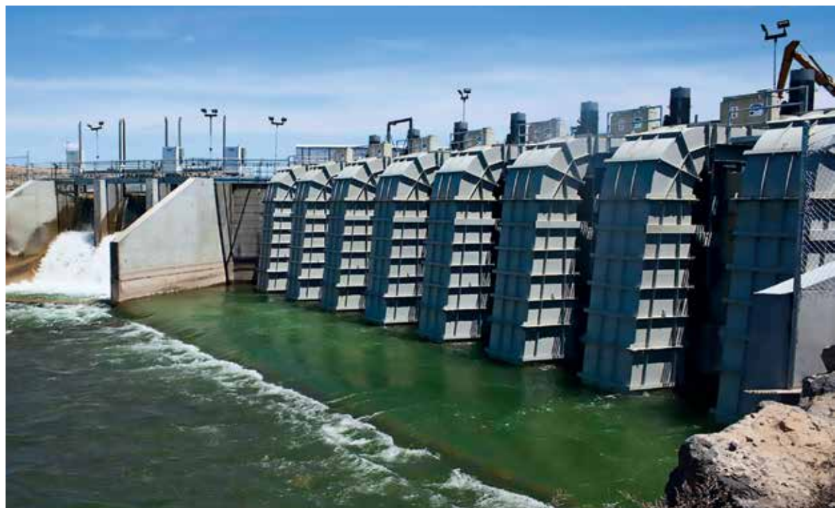
ČESKÉ TURBÍNY NA AMERICKÉ VODĚ. Osm zařízení na výrobu elektrické energie od společnosti Mavel našlo uplatnění poblíž městečka Jerome ve státě Idaho. Stejná zařízení poslal Mavel do Kazachstánu.
