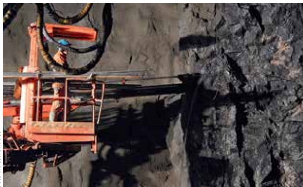
PĚT METRŮ. Tak hluboko do skály vrtají tuneláři pod Helsinkami, o tolik postoupí po každém odstřelu.
