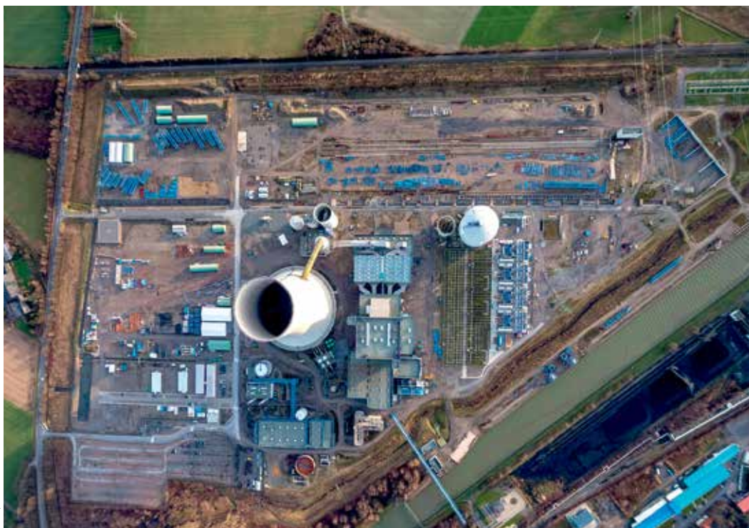
ELEKTRÁNA I TEPLA. Uniper v Porúří dokončuje stavbu nadkritického černouhelného bloku Datteln 4 o instalovaném výkonu 1100 MW. Elektrárna by v roce 2018 měla kromě elektřiny dodávat také teplo.
