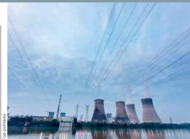
DUKOVANY ČEKÁJÍ NA NOVELU. Změna v zákoně by zkrátila dobu výstavby nového jaderného bloku až o tři roky.
