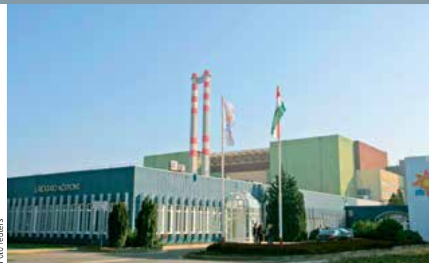
PAKS. Maďarská jaderná elektrárna, která nyní vyrábí takřka polovinu energie země, dostane dva nové reaktory.
