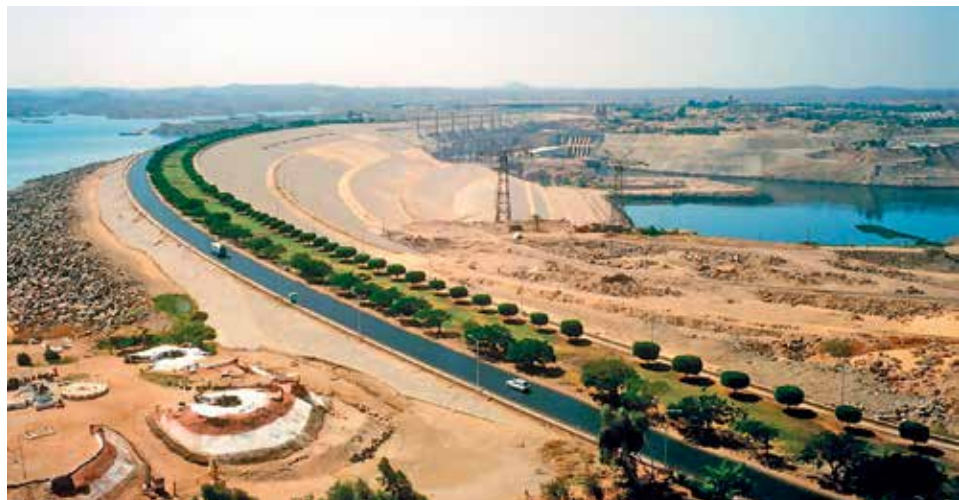
HRÁZ. Novější přehrada je dlouhá 3,8 kilometru.
