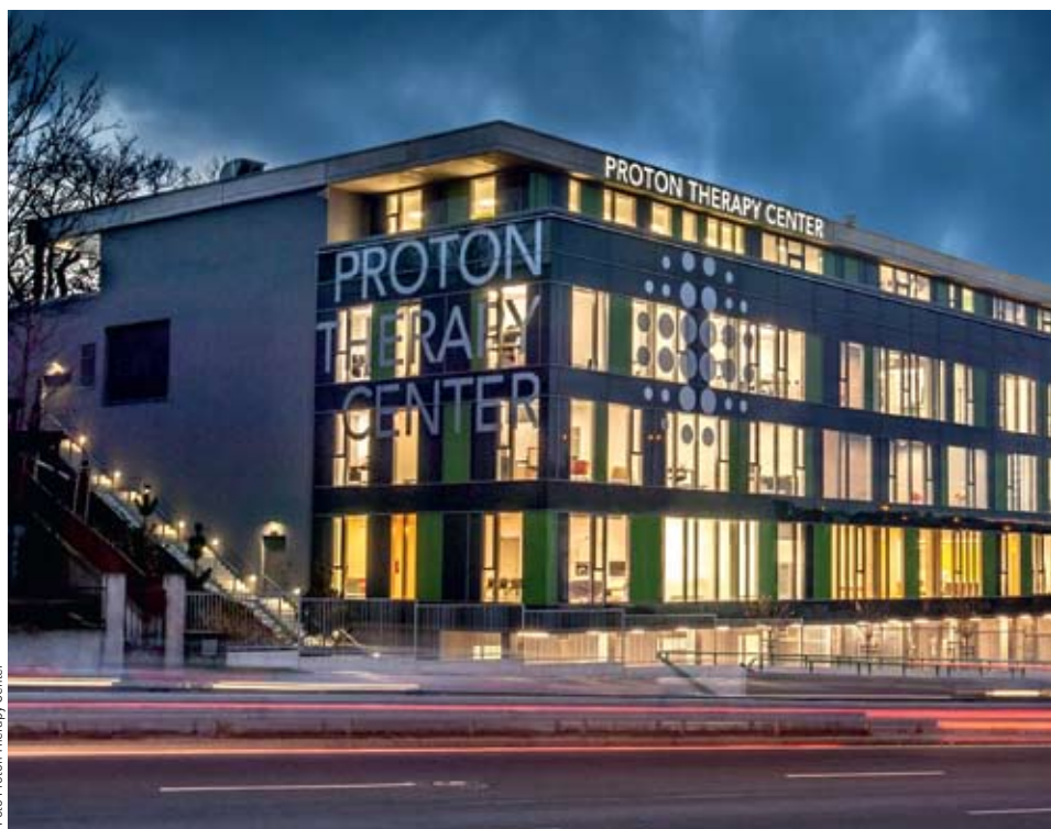
MILIARDOVÁ INVESTICE. Protonové centrum Praha otevřeli bratři Václav a Pavel Laštovkovi v roce 2012, jeho výstavba stála 3,5 miliardy korun.
