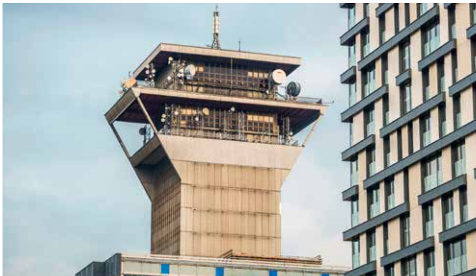
VĚŽ ZMIZÍ. Výraznou dominantu Žižkova čeká demolice. Budoucí majitel na jejím místě plánuje postavit bytové domy.
