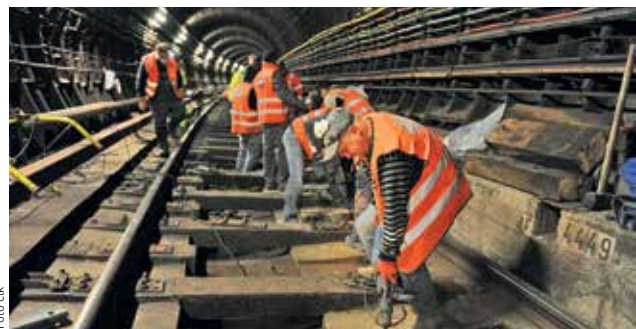
BRZY PO NOVÉM. Výměna 452 dřevěných prážců za betonové vyjde na 18 milionů korun.
