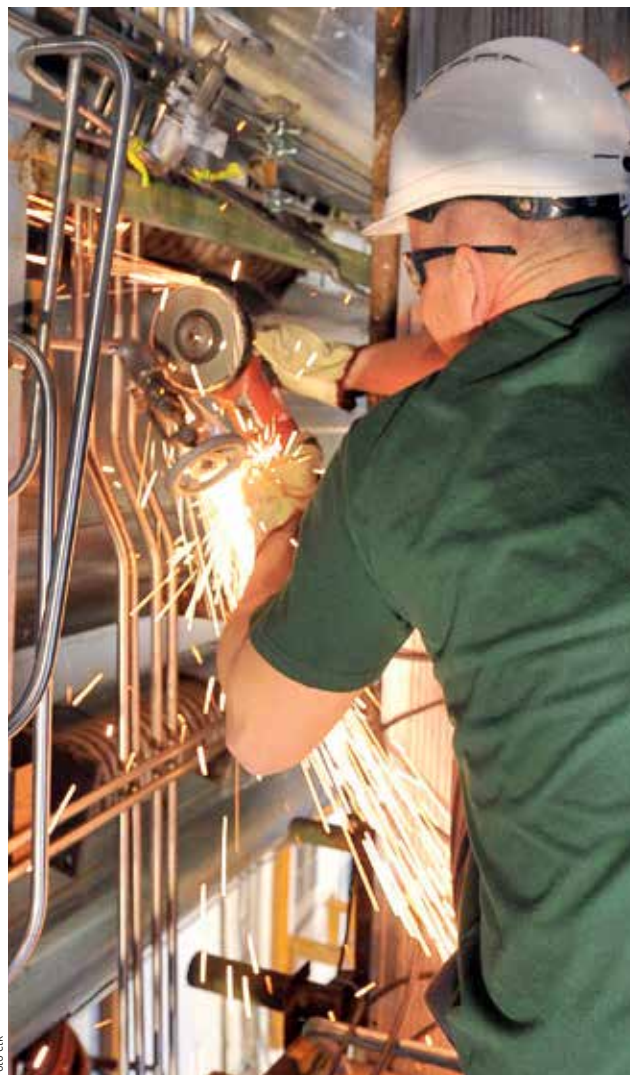
ODSTÁVKA. Technici na nejaderné části Elektrárny Dukovany počátkem loňského prosince kontrolovali a opravovali svařky, kvůli nimž byly od září odstaveny tři ze čtyř bloků elektrárny.
