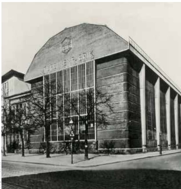
HISTORICKÝ ODKAZ. Nyní památkově chráněná továrna společnosti AEG architekta a designéra Petera Behrense.
