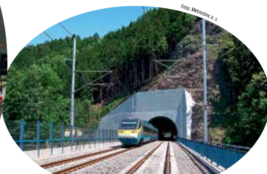
Ze stezky jsou dobře vidět portály nových hněvkovských tunelů.
