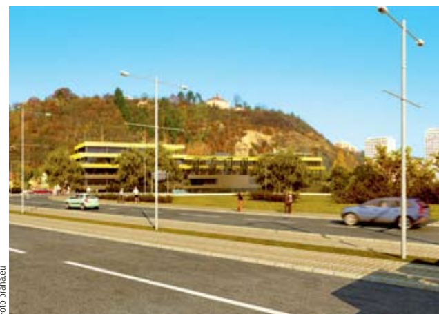
ZÁCHRANKA V TROJI. Dříve zde bylo hřiště, posléze zázemí pro stavbu Trojského mostu a Bubenečského tunelu.
