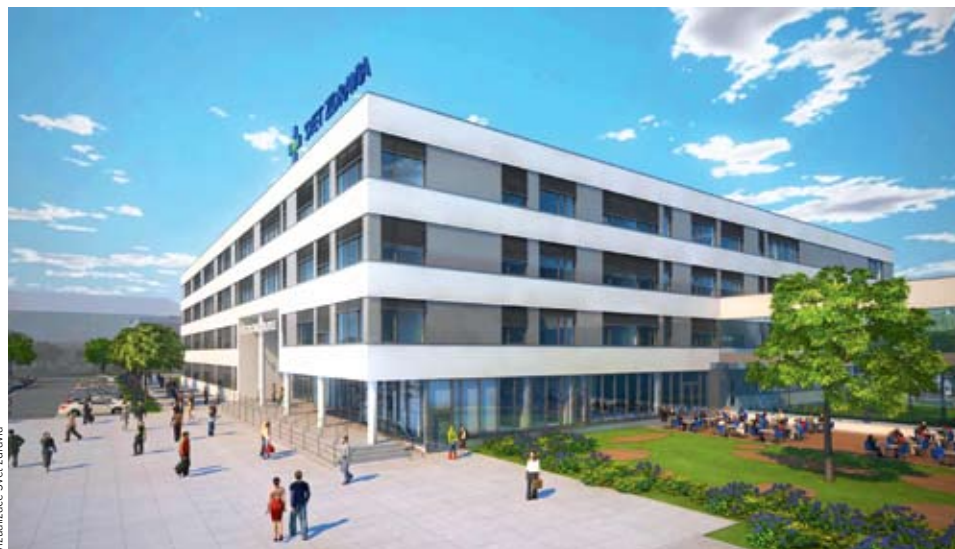
MODERNÍ PROJEKT. Investiční skupina Penta staví v Michalovcích nemocnici nové generace s kapacitou 381 lůžek, která začne poskytovat péči v roce 2018.
