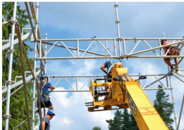
SPOUSTA PRÁCE. Z lávky končící nad vodní hladinou by se měl do jezera spustit tobogan. Nejprve je ale třeba smontovat lešení.
