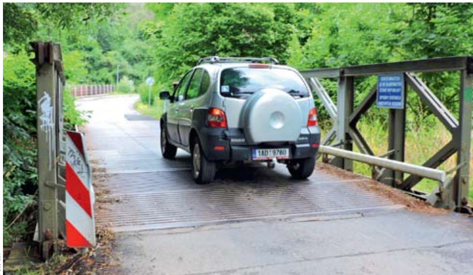
JEN JEDNO AUTO. Provizorní mosty slouží k zajištění nouzové dopravy hlavně při povodních. Jejich parametry už ale přestávají vyhovovat.
