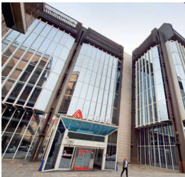
K DEMOLICI. Kancelářské centrum za Národním muzeem na začátku Vinohradské třídy by mělo ustoupit novému, modernímu.
