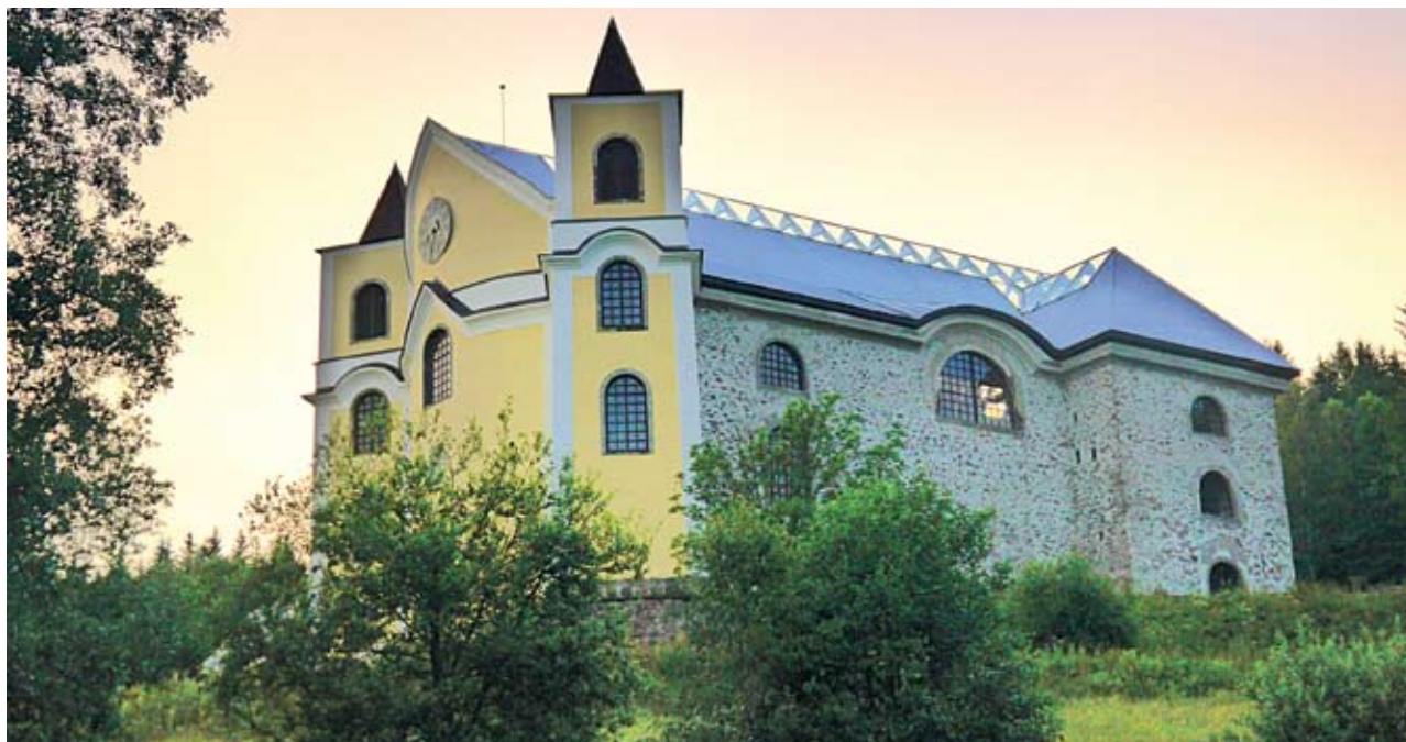
SVATOSTÁNEK. Neratovský kostel o půdorysu ve tvaru kříže má konvexní průčelí se dvěma nakoso postavenými věžemi. Jeho délka činí 48 a šířka 19 metrů.
