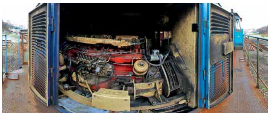
Strojovna s kompresorem
