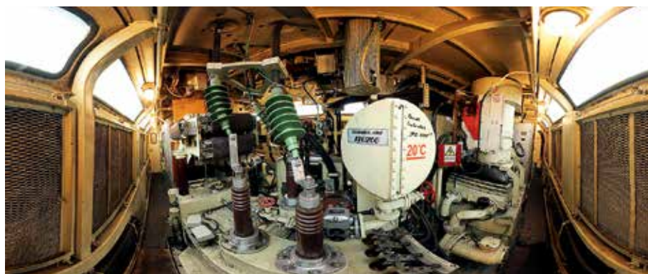
Strojovna s dominujícím kompresorem.
