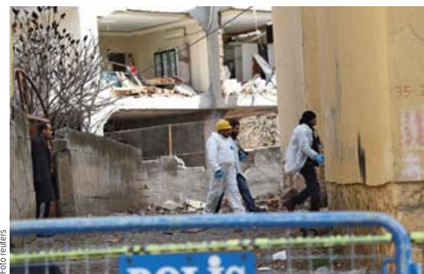
ÚTOK NA POLICEJNÍ STANICI. Po explozi nákladního auta s výbušninou následoval útok raketovými a pěchotními zbraněmi, při němž byla policejní stanice poškozena.
