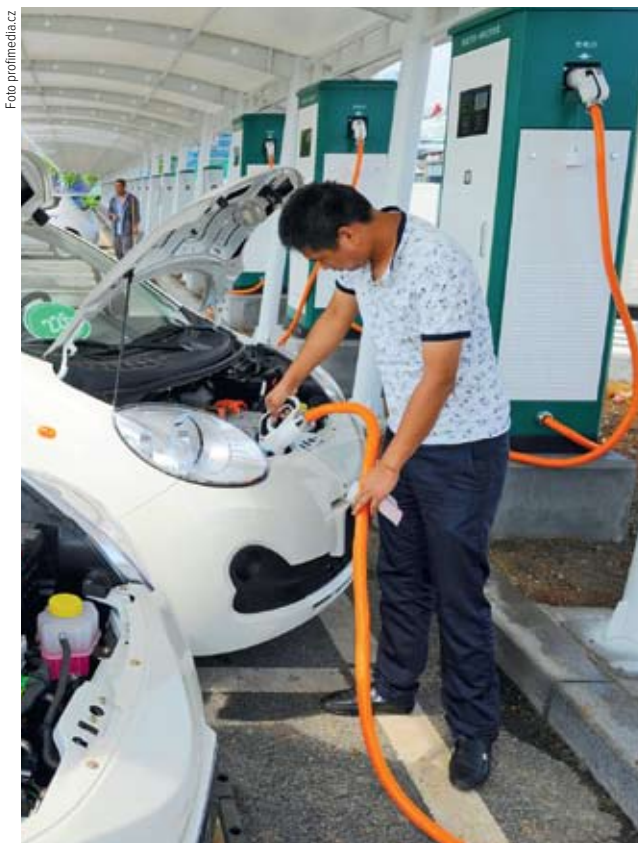
PŘEKÁŽKA. Rozvoji elektromobility brání nedostatek dobíjecích míst. Čínská vláda to ví, proto jich chce v zemi na pět milionů.
