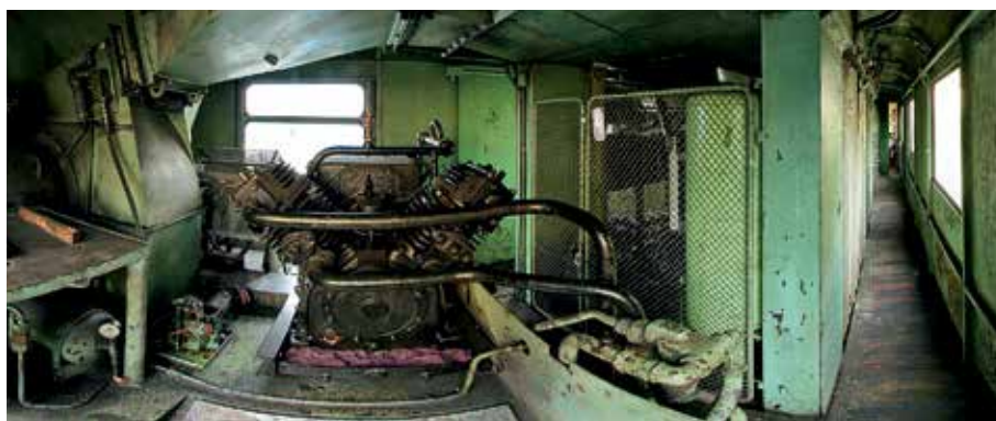
Strojovna s dominujícím kompresorem.
