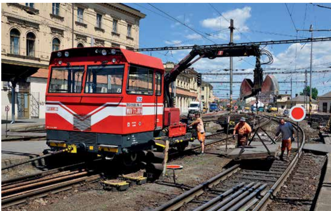
V roce 2013 proběhla velká výluka na brněnském hlavním nádraží.
