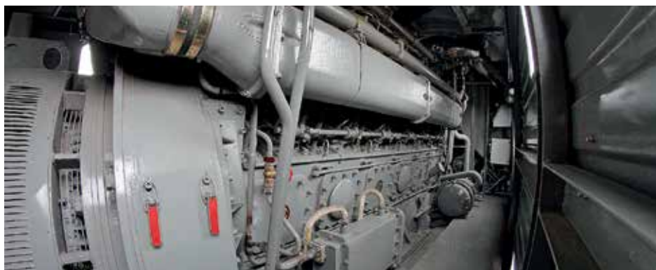
Pohled do strojovny na trakční dynamo a motor K 12 V 230 DR.
